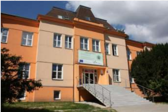
Budova H Ústav Technologií a Materiálů
