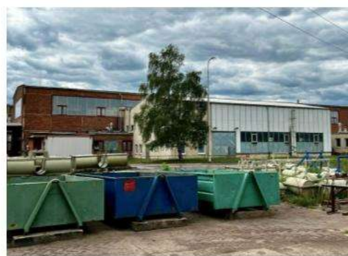
Komořany, kolejové depo
