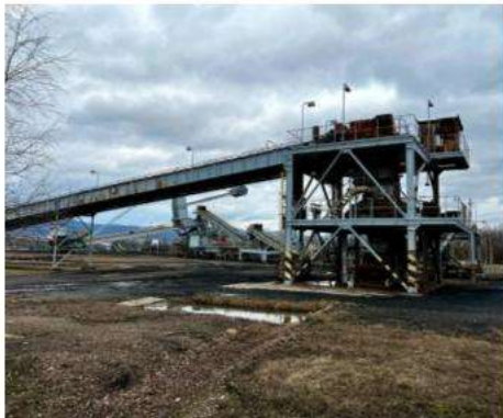
Komořany, technologická infrastruktura
