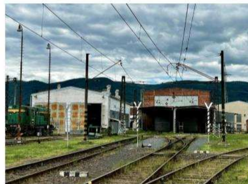
Komořany, kolejové depo
